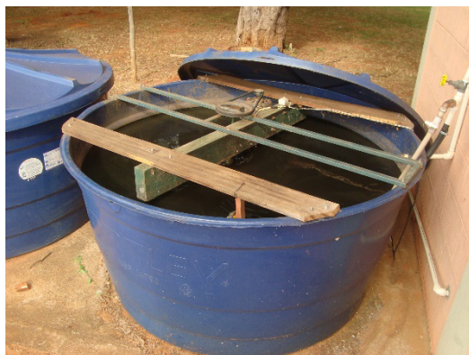
Figura 02. Lodo no reservatório de lodo de 2.000L com agitador
