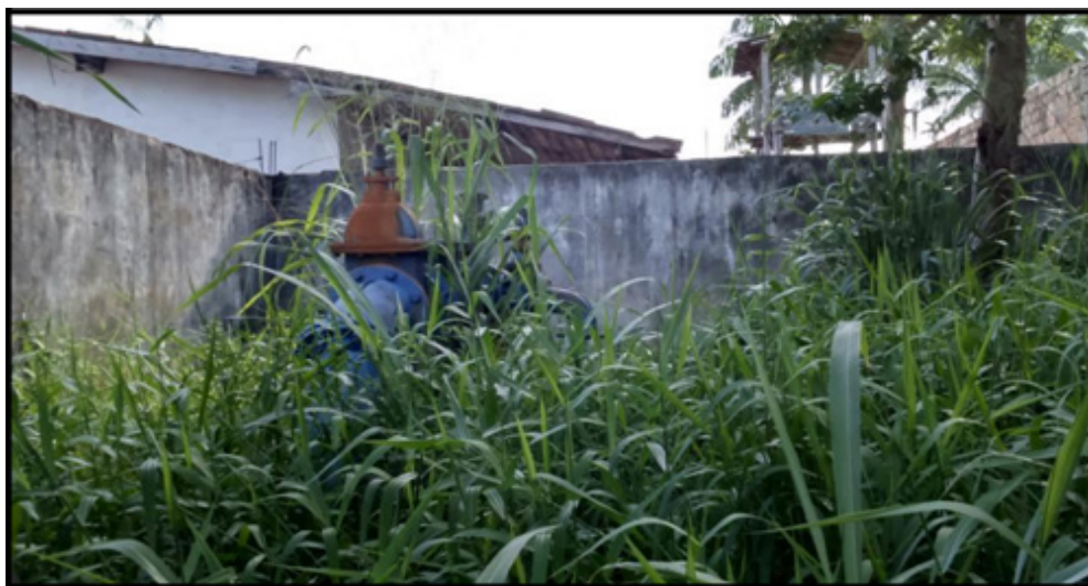
Figura 4: Condição da área do poço 7.
