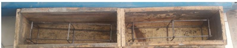
Figura 3 - Armaduras e fôrmas utilizadas (Autor)
