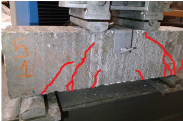
Figura 32 – V05-A fissuras após o ensaio.
