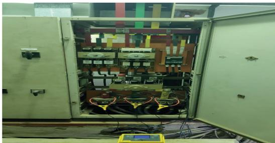
Figura 7 - Conexão do medidor no barramento secundário de T1
