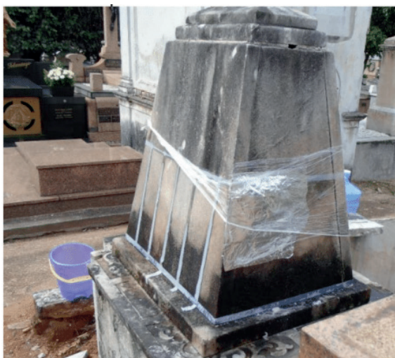
Figura 2: S/I - Túmulo abandonado Testes de limpeza no mármore
