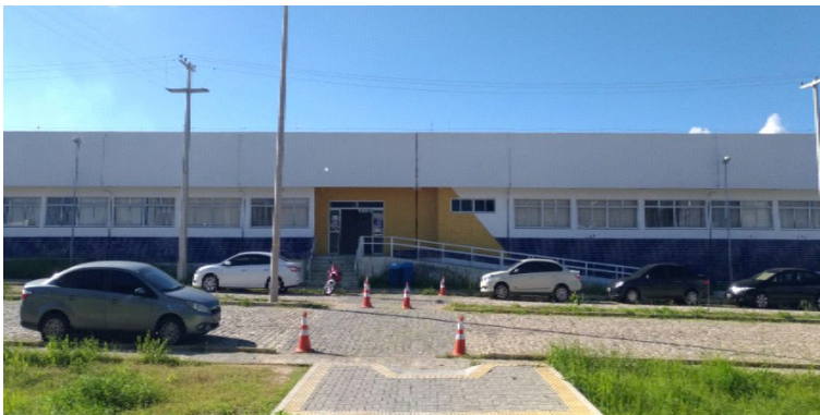
Imagem 02 – Bloco de salas dos professores da UFERSA, campus Pau dos Ferros
