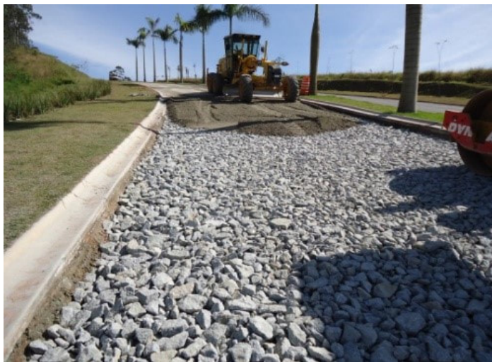
Figura 21 – Recapeamento e pavimentação utilizando lodo, retirado do resíduo final do tratamento de águas
