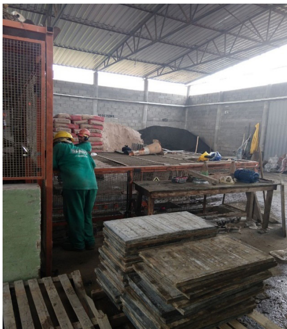
Figura 2 - Bandejas em chapas metálicas.
