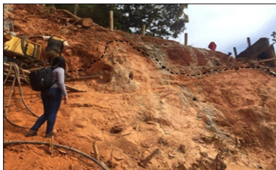
Figura 9. Encosta com contato de solos residuais maduros de gnaisse e rocha básica.
