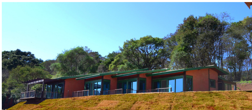
Figura 16 – Foto final da edificação unifamiliar (crédito: A. Caninéo, 2017)
