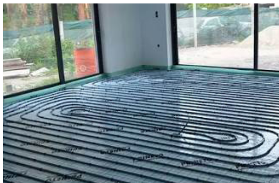
Figura 12 - Instalação do sistema de piso radiante hidráulico
