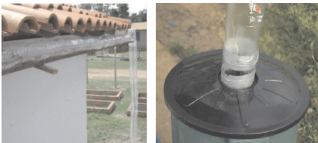
Figura 1 - Calha feita com garrafa PET.
