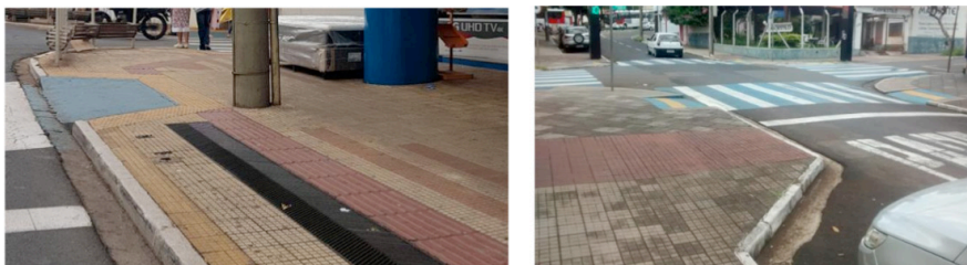
Figura 11: Acima: Araraquara Rua Nove de Julho (Sinalização tátil direcional e de alerta com diferenciação cromática. poste de iluminação locado incorretamente sobre a faixa de circulação, uso do espaço público para fins privados por parte de comerciantes locais). Abaixo: São Carlos - Cruzamento da Av. General Osório com Rua Riachuelo: Redução da travessia através de medidas de Traffic Calming . Fotos das autoras.
