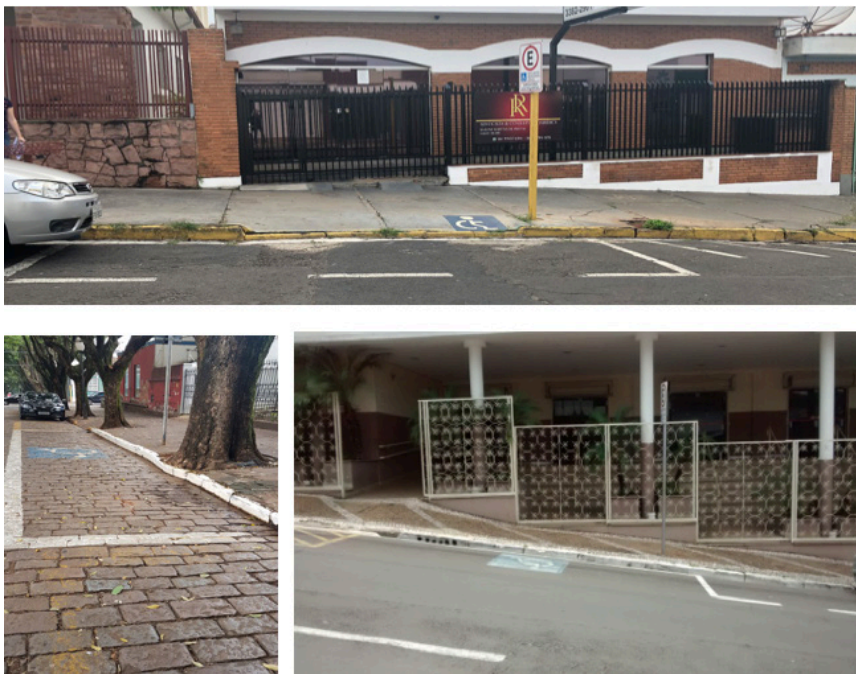
Figura 7: Acima: Matão. A vaga reservada para PCD está implantada em frente à garagem de uma edificação particular. À esquerda: Araraquara (vaga implantada em pavimento trepidante, ausência de faixa de transferência, rebaixamento e passeio irregulares. À direita: São Carlos (vaga implantada em via estrutural de fluxo intenso e alta velocidade, com declividade acentuada). Fotos das autoras.
