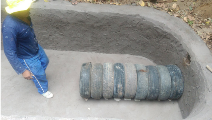
Figura 3: Empilhamento de pneus para câmara anaeróbica.
