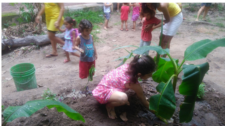
Figura 9: Plantação da vegetação sobre o TEvap.
