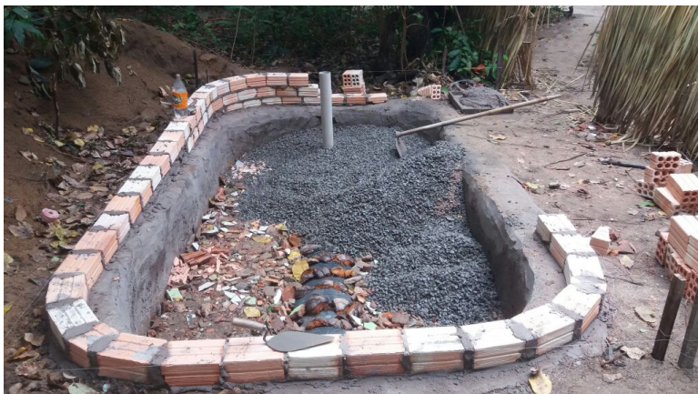
Figura 5: Adição da camada de brita.
