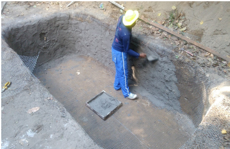
Figura 2: Revestimento com ferro-cimento.
