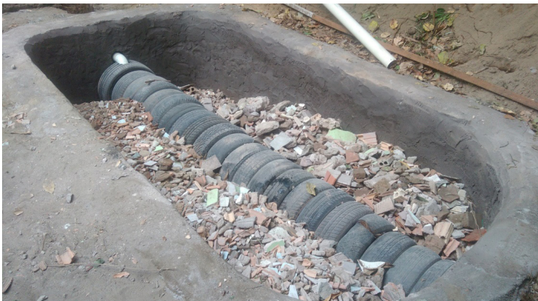
Figura 4: Colocação da camada de entulho de construção.
