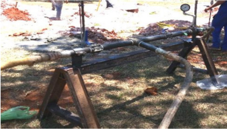
Figura 5. Sistema de bomba para injeção dos EB.
