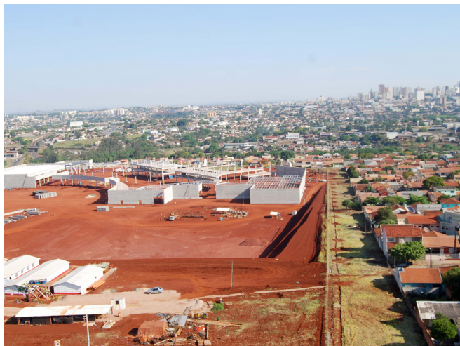
Figura 7 – Construção do Londrina Norte Shopping, em 2011
