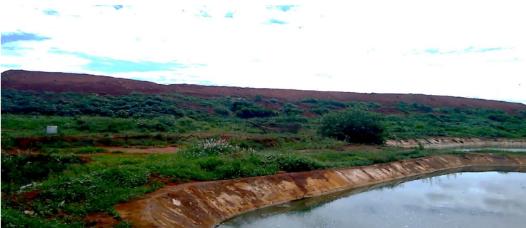
Figura 3: Visão Frontal do Maciço de Resíduos no Aterro.
