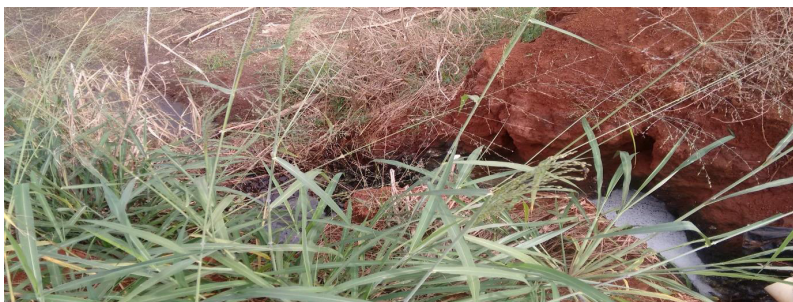
Figura 7: Lançamento de chorume não tratado diretamente no solo.
