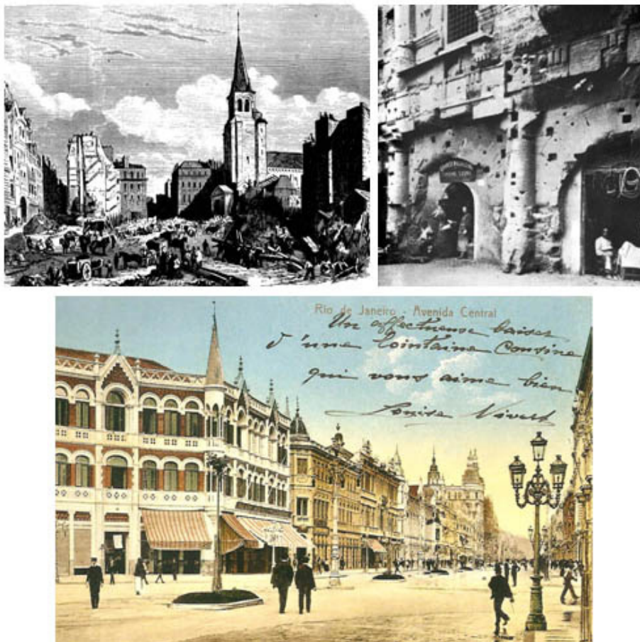
Figura 2 – (esquerda acima): Demolições para a abertura da Rue de Rennes – gravura publicada em Illustration de 1868 . Fonte: BENEVOLO, 1999. p. 591. (direita acima): As lojas do carvoeiro e do soleiro no térreo do antigo Teatro de Marcelo - Roma, antes das demolições do período Fascista. Fonte: BENEVOLO, 1999. p. 183. (abaixo): Av. Central com Visconde de Inhaúma no Rio de Janeiro em 1911 – Modernidade de Pereira Passos.
