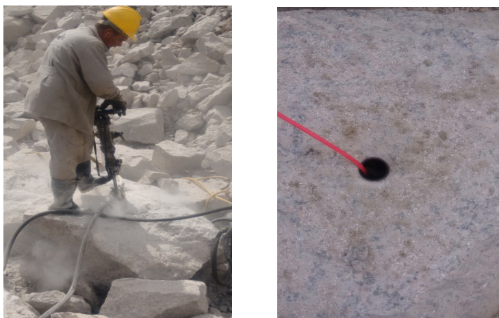
Figura 2 - Perfuração dos matacões, preparação para o desmonte secundário
