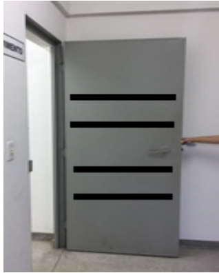
Figura 11 – Contraste nas portas da escada de emergência
