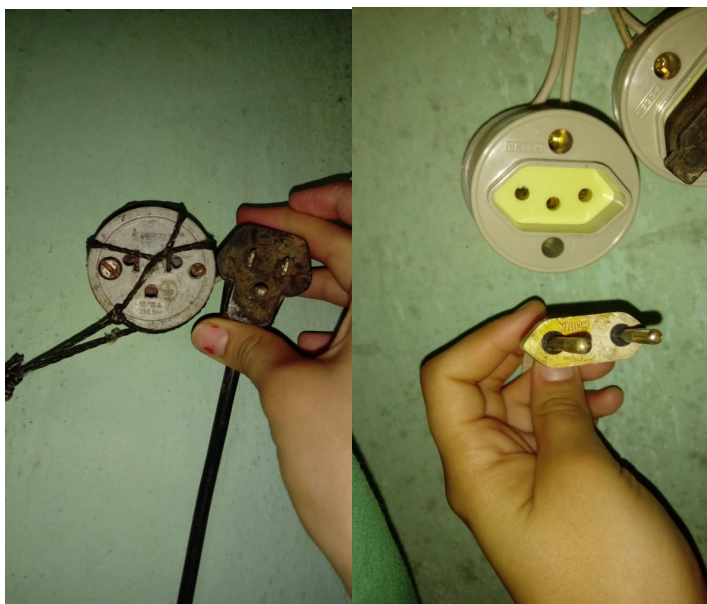
Figs. 14 e 15: Antes e depois de uma instalação de tomada. Nesse caso em questão também foi trocado o plugue do eletrodoméstico alimentado para encaixar na nova tomada, além de inseri-lo em um modelo atualizado e mais de acordo com as novas normas de modelo para plugues e tomadas.
