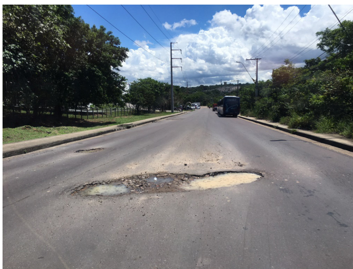
Imagem 3: Pavimentação da Avenida Otis
