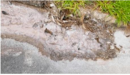
Figura 8: Boca de Lobo completamente obstruída
