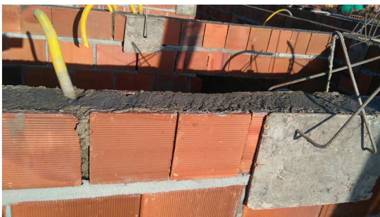
Figura 2. Cintas de amarração com bloco canaleta.
