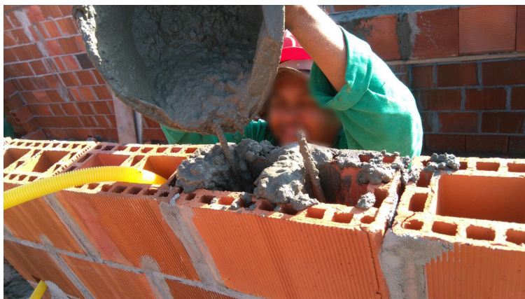
Figura 1. Preenchimento com graute.
