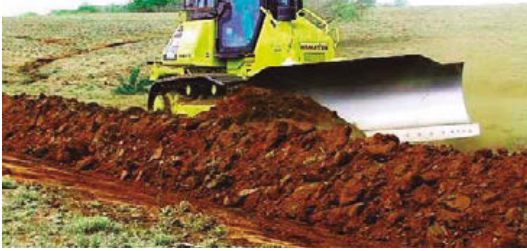
Figura 3 A e B - Terraceamento em área de recarga hídrica.
