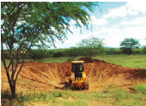
Figura 4 A e B - Obra de construção de bacias para captação (barraginhas) de água de chuvas e de sedimentos.
