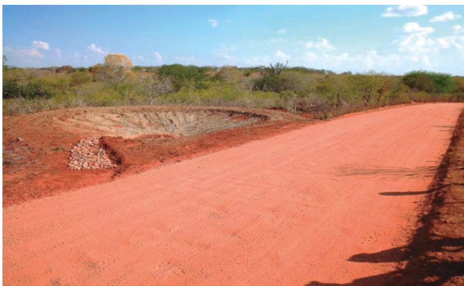
Figura 5 - Adequação de estrada rural associada à bacia de captação de enxurrada.
