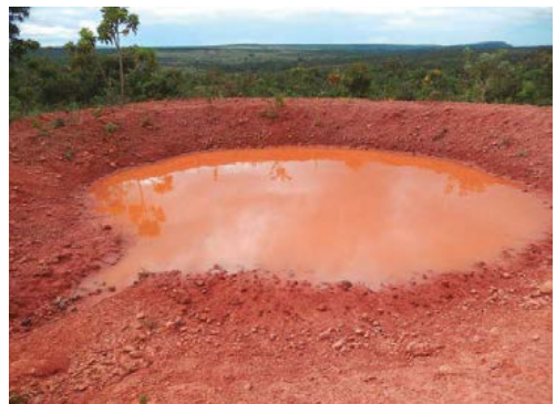
Figura 4 A e B - Obra de construção de bacias para captação (barraginhas) de água de chuvas e de sedimentos.
