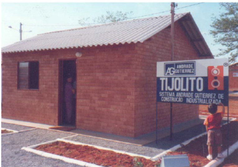
Figura 5 - Casa construída em Brasília – Distrito Federal - 1992
