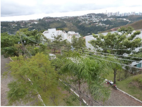
Fotos 10, 11, 12, e 13: Conflito do cabo dupla camada com arborização nos 2 trechos após 9 meses durante e após a instalação do cabo dupla camada
