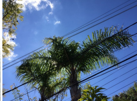
Fotos 14 e 15: Conflito do cabo dupla camada com arborização nos 2 trechos após 18 meses
