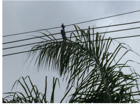
Fotos 10, 11, 12, e 13: Conflito do cabo dupla camada com arborização nos 2 trechos após 9 meses durante e após a instalação do cabo dupla camada
