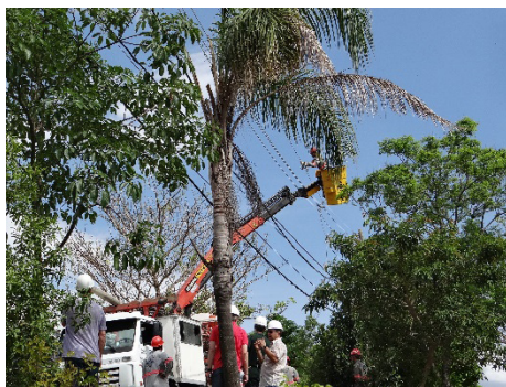
Fotos 4 e 5: Trecho do 2º projeto piloto durante e após a instalação do cabo dupla camada
