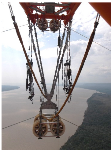
FIGURA 7 – Lançamento dos cabos
