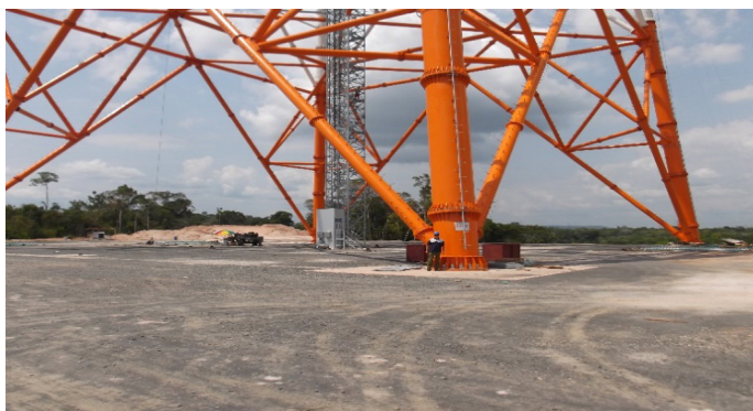
FIGURA 3 – Montante da Torre
