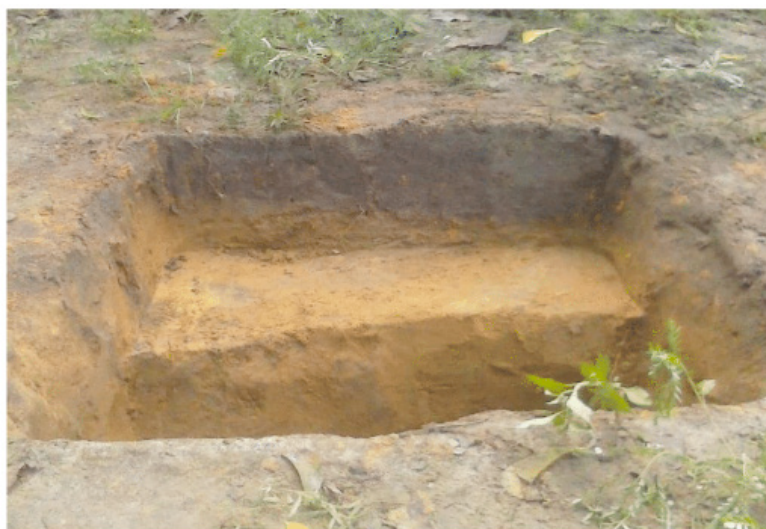
Figura 2 – Mini trincheira aberta no terreno da escola.
