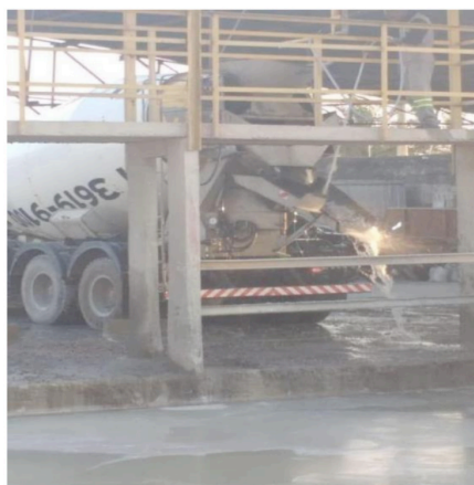
Figura 2: Lavagem dos caminhões betoneira
