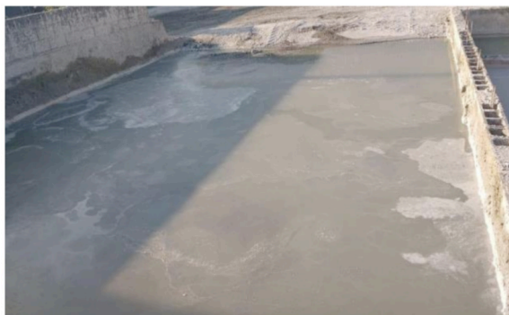
Figura 5: Tanque receptor de água oriunda da lavagem dos caminhões
