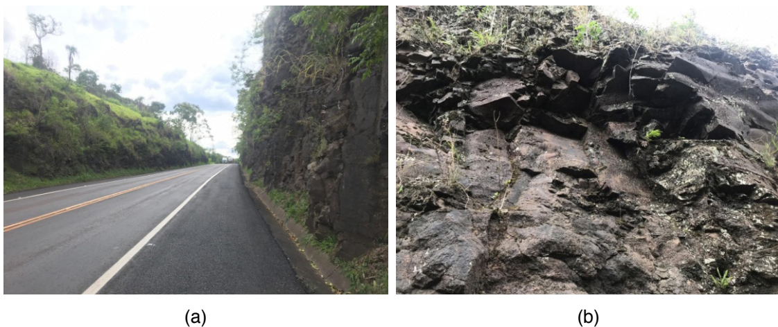
Figura 8 – Rodovia BR-376 km 241+25 LD/LE (a) vista do talude rochoso (b) detalhe de uma porção desse talude, sem ocorrência de deslocamento ou queda de bloco rochoso.
