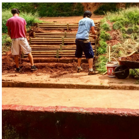
Figura 23 e 24: Construção da escada/arquibancada para o campo de futebol.
