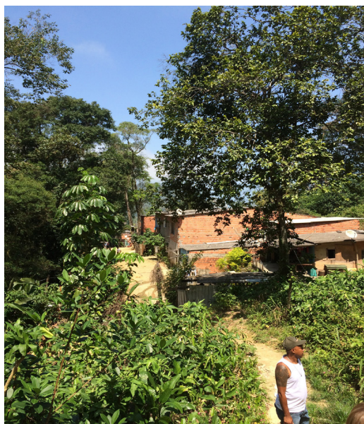
Figura 4: Residência em área de risco em São Sebastião
