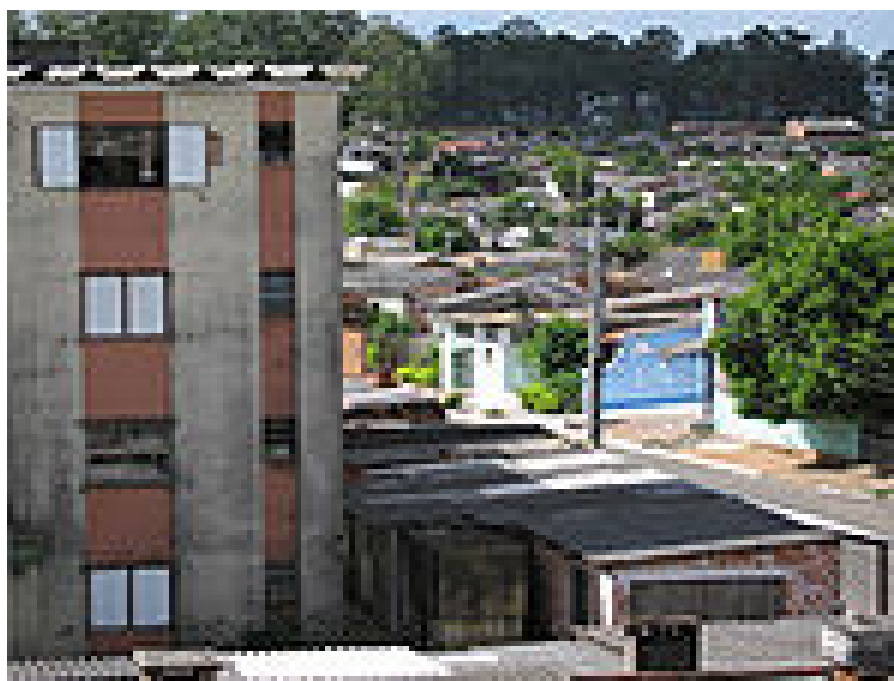
Figura 5 - Prédio do Conjunto Habitacional Ildo Meneghetti e casas de ocupações posteriores
