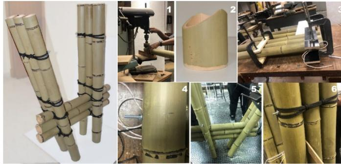
Figura 5. Modelo finalizado do detalhe da cobertura de bambu, etapas 1, 2, 3, 4, 5, 6: Fotos do processo de execução do modelo
