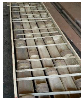
Figura 8 - Disposição das taliscas na laje com nós. Fonte: Elaborado pelos autores.
