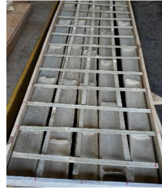
Figura 5 - Malha de taliscas. Fonte: Elaborado pelos autores.
