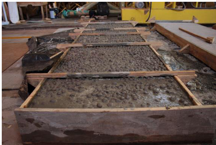
Figura 9 - Laje após concretagem.
