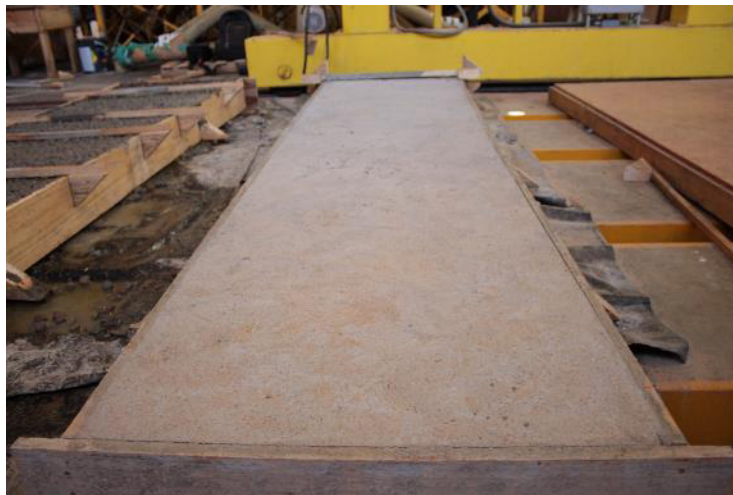
Figura 10 - Laje após regularização da capa.
