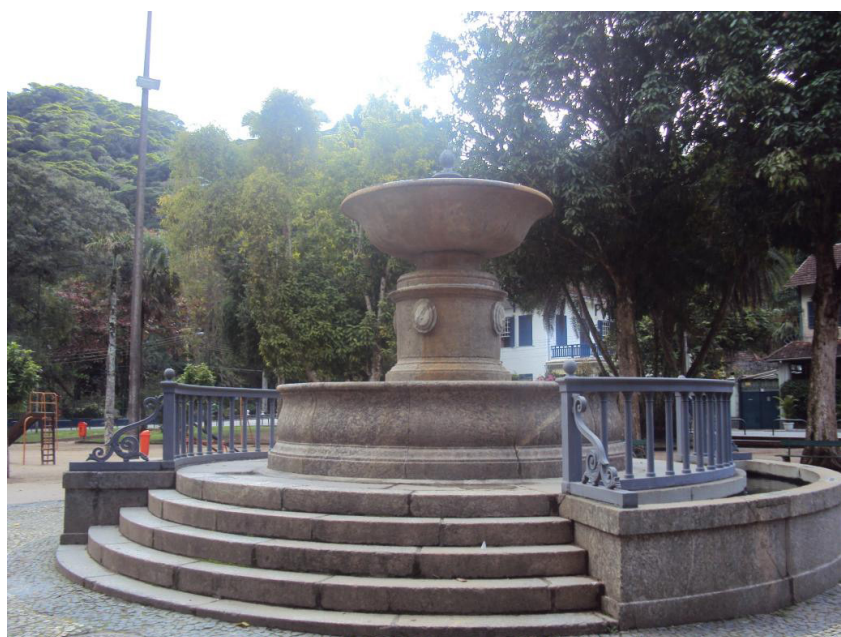
Figura 2. Chafariz em cantaria da Praça Afonso Viseu, projeto do arquiteto francês Grandjean de Montigny.
