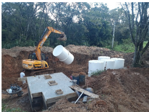
Figura 2: Obra e instalação
