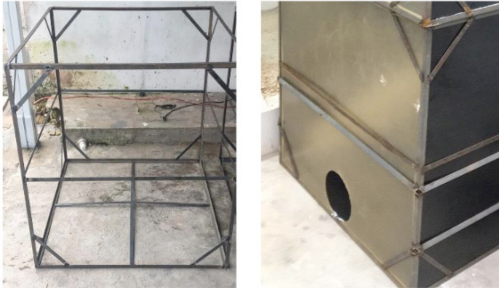
Figura 1 – estrutura metálica do sistema piloto com o madeirite e acrílico
