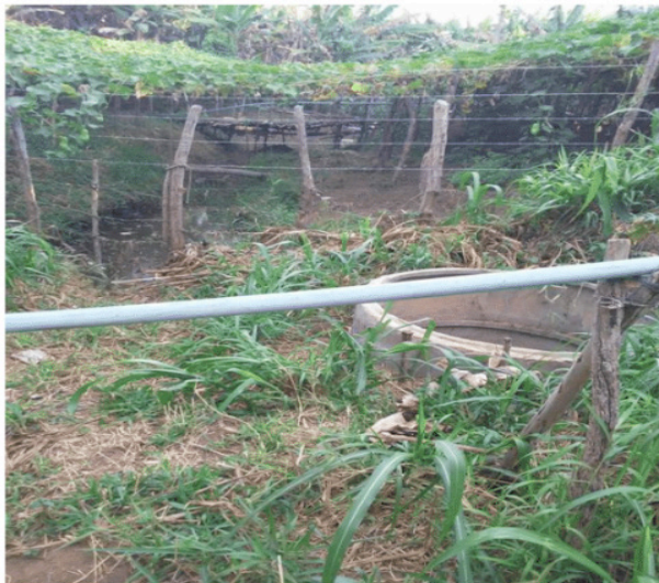
Figura 2: Cacimbão dentro da área da nascente
