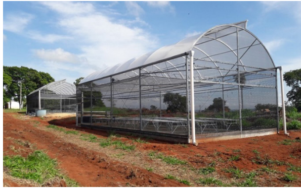
Figura 5. Estufa agrícola coberta com filme de polietileno de baixa densidade. Cassilândia –MS, 2017.
