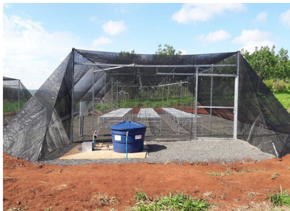
Figura 4. Ambiente protegido, do tipo telado agrícola com tela de monofilamento preta. Cassilândia – MS, 2017.
