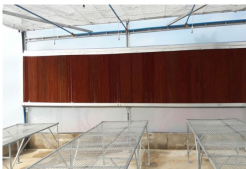
Figura 8. Interior de uma casa de vegetação climatizada, com sistema de climatização pad fan. Cassilândia-MS, 2017.
