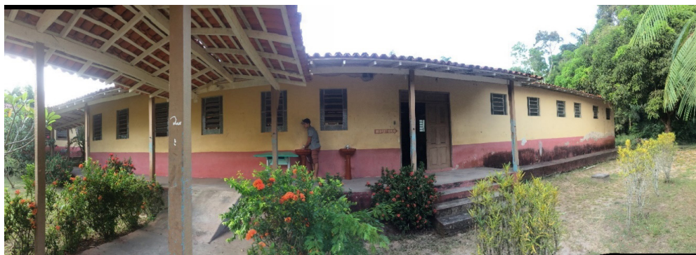
b) Vista frontal do prédio do refeitório.
