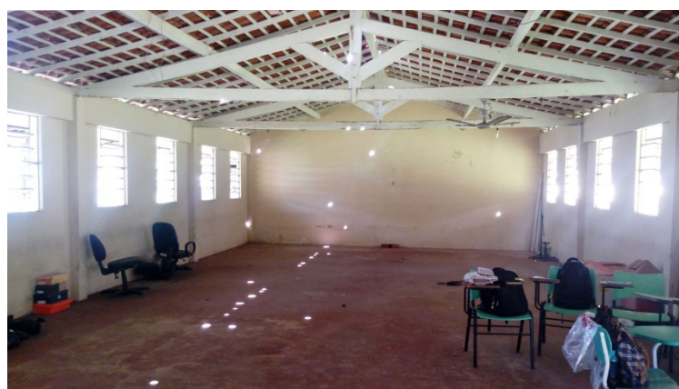
c) interna do refeitório.
