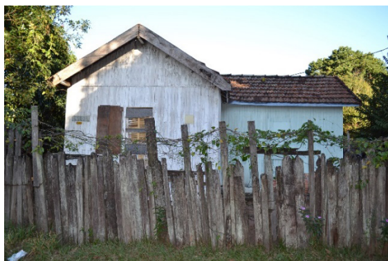
Figura 1 – Casa em madeira, vila ferroviária de São Carlos.
