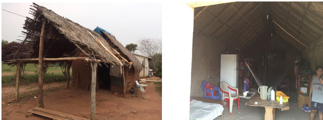
Figura 11: Vivienda con punilla - Vista externa (izq.), vista interna (der.)
