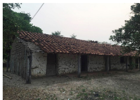
Figura 09: Vivienda con doble Corredor
