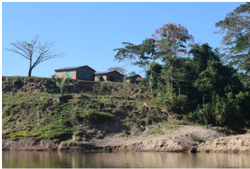
Vista de las viviendas desde el arribo por el río Acre
