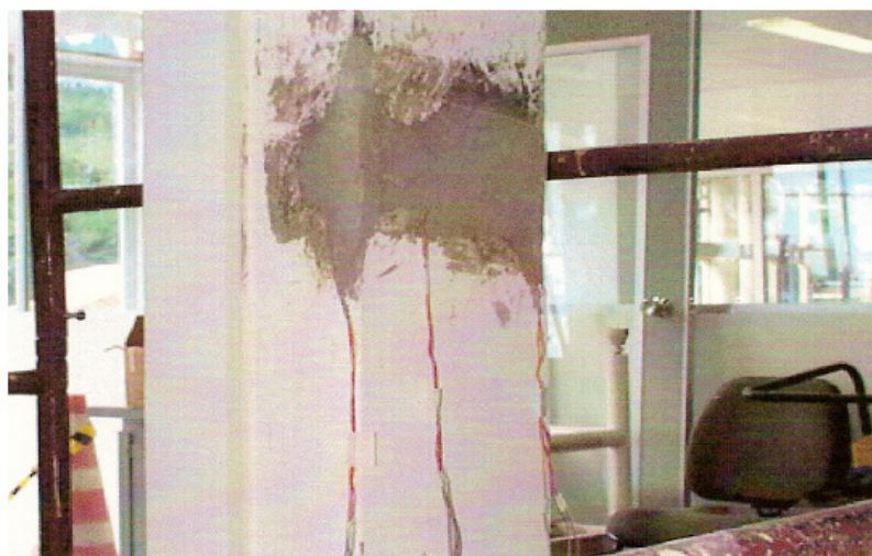
FIGURA 6: Instrumentação das armaduras do pilar central (recuperação após a instrumentação)
