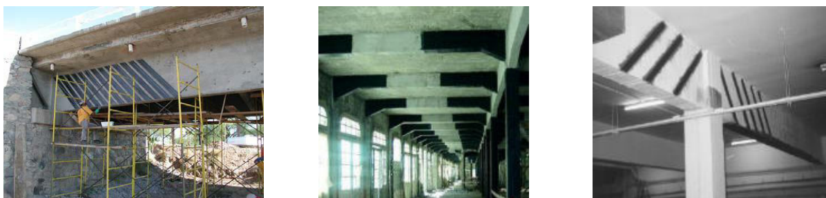
Figura 1 – Vigas Reforçadas ao Cisalhamento com PRFC.
