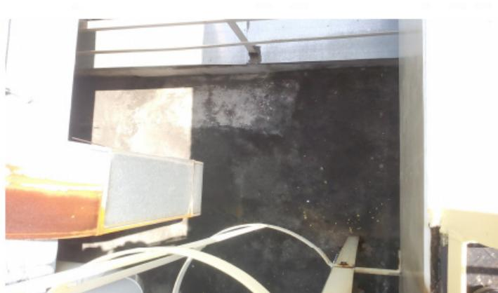
Figura 07: Desnível negativo no recolhimento de águas pluviais
