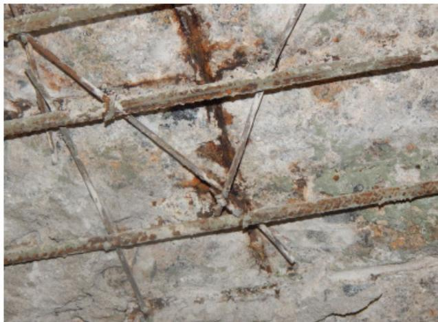
Figura 04: Ancoragem e espaçamento da armadura inadequada (Próprio Autor (2018))
