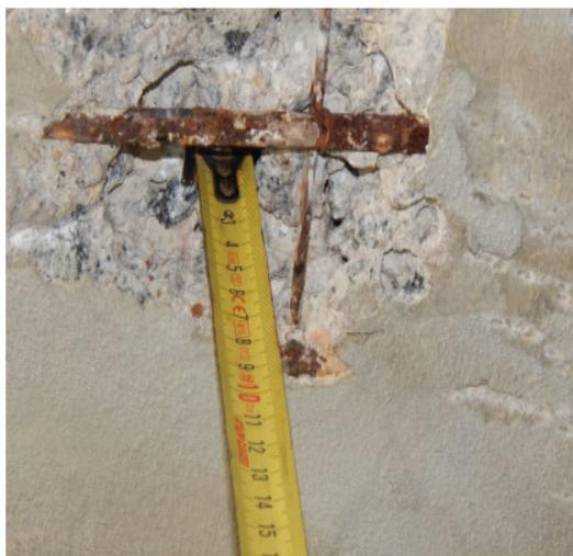
Figura 03: Falta cobertura de armadura (Próprio Autor (2018))
