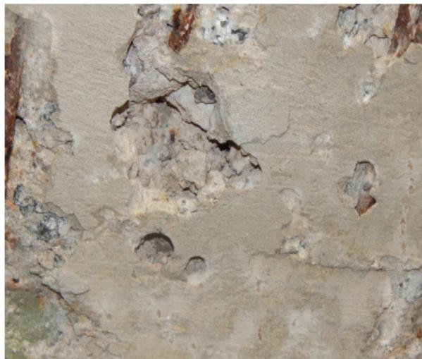
Figura 11 – Ausência de vibração na hora da concretar (Próprio Autor (2018))
