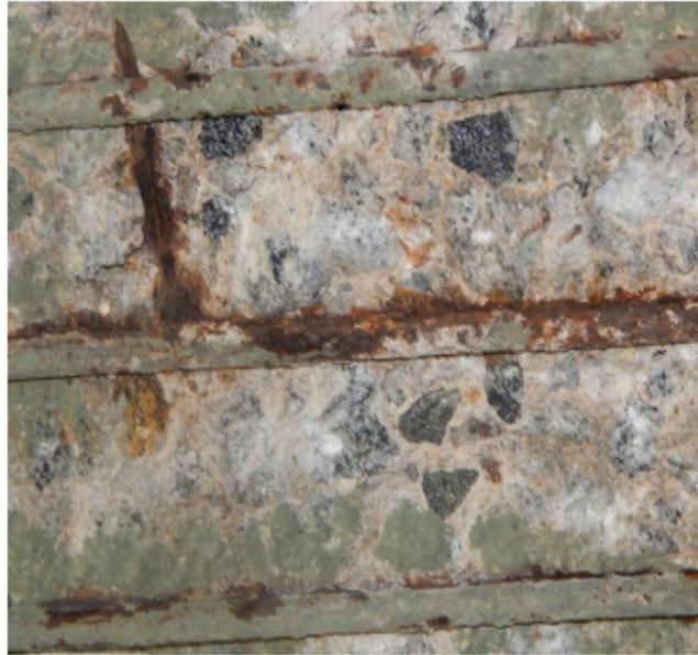
Figura 06: Ausência de padrão granulométrico (Próprio Autor (2018))
