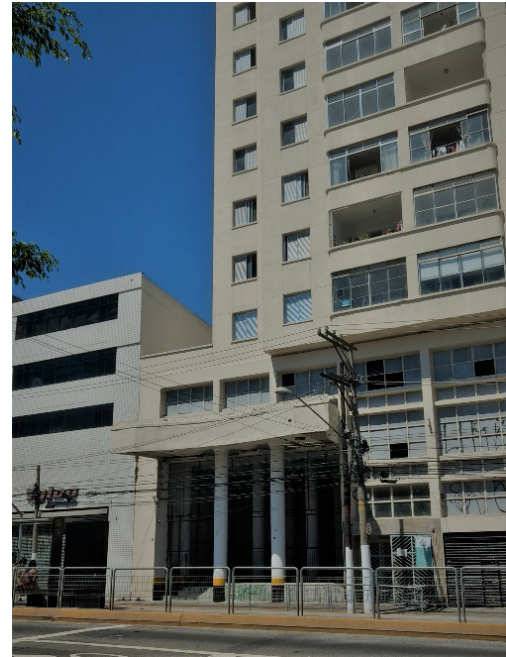
Figura 12 –Fachada do Cine Piratininga atualmente, 2017
