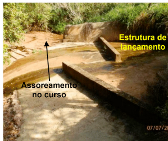
Figura 20 – Assoreamento no curso d'água após lançamento de água da BD
