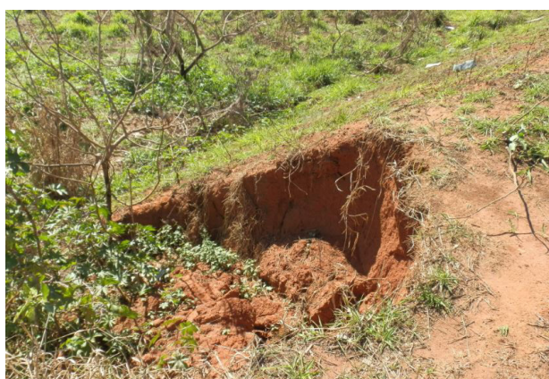
Figura 13 – Erosão nos taludes (Exemplo 1)
